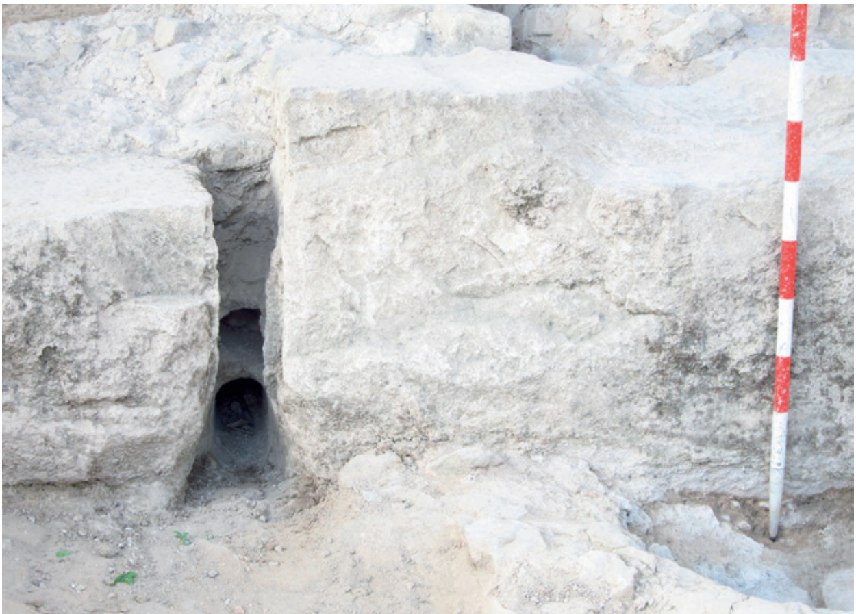
FIGURA 24A i 24B. Detall del desguàs de la natatio . A la part interior podem veure l'embocadura amb una gran peça de plom, i a l'exterior els dos forats de desguàs que permetien controlar-ne el buidatge.
